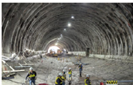
浜坂道路Ⅱ期トンネル建設工事
