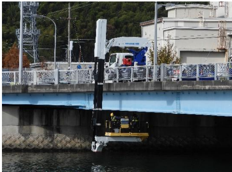
橋梁点検車による点検状況（洲本市潮橋） 「ひょうご橋守隊」活動状況（丹波篠山市奥山上橋）
