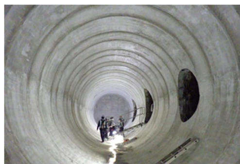
津門川地下貯留管他整備工事
