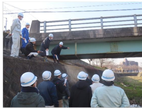
橋梁点検 0JT
