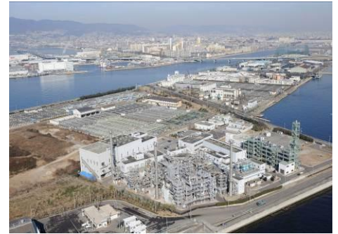
兵庫東スラッジセンター
