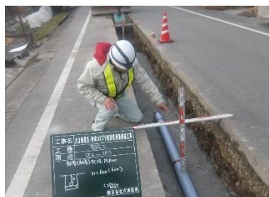
管路接続工事 (大山処理区・神崎第一処理区)
