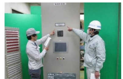
温泉中央浄化センター 監視装置改築工事
