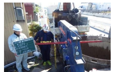
松帆湊汚水管渠布設工事
