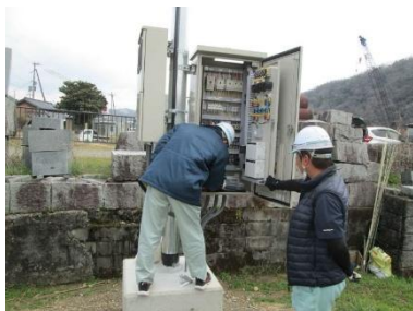
マンホールポンプ制御盤設置 (上月処理区統廃合)
