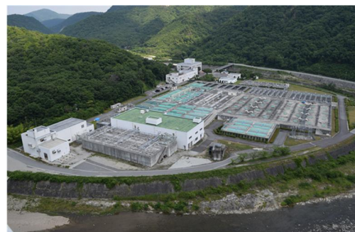
武庫川上流浄化センター
