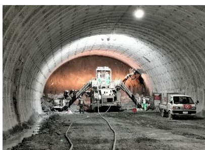
浜坂第2トンネル(仮称)建設工事(新温泉町)
