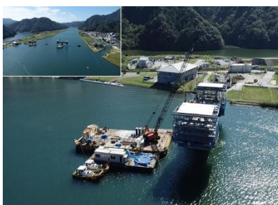
城崎大橋上部工事(豊岡市)
