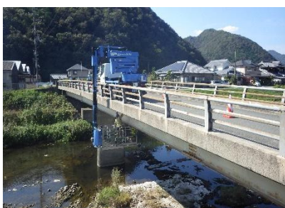
橋梁定期点検(橋梁点検車)
