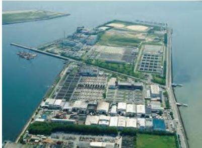
武庫川下流浄化センター(尼崎市)
