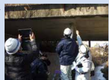
直営点検支援の状況
