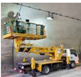
トンネル点検状況
