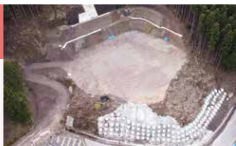
災害復旧工事(地すべり)
