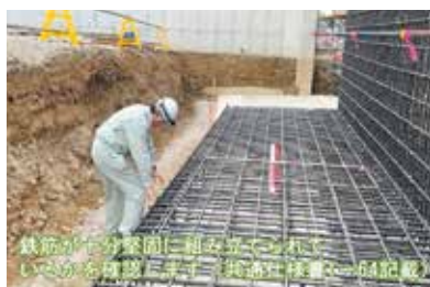
【第2弾】配筋検査(基礎編) [R6.3公開]
