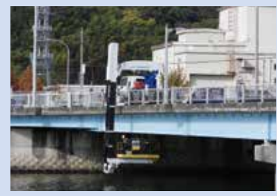
橋梁点検車による点検状況
