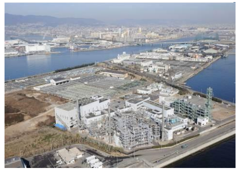
兵庫東スラッジセンター
