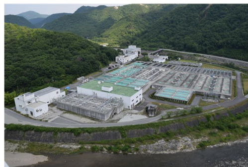
武庫川上流浄化センター
