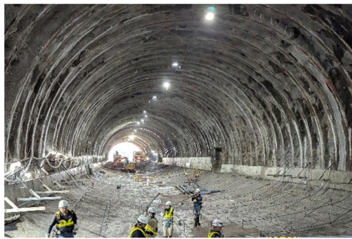
浜坂道路Ⅱ期トンネル建設工事
