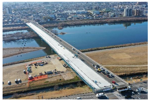
加古川橋上部工工事
