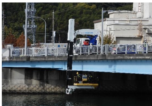
橋梁点検車による点検状況
