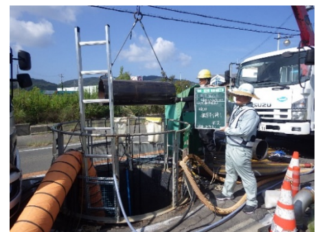
汚水管渠布設工事(南あわじ市)
