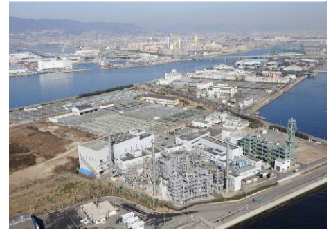
兵庫東スラッジセンター
