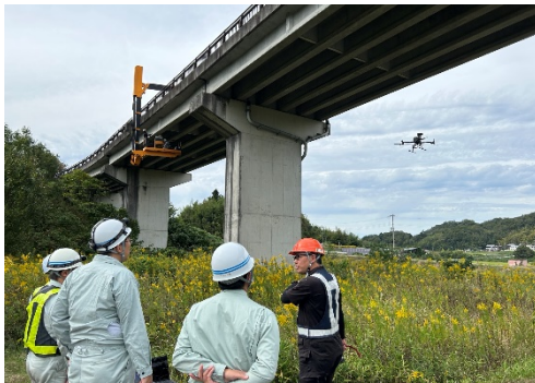
橋梁点検車等による点検状況
