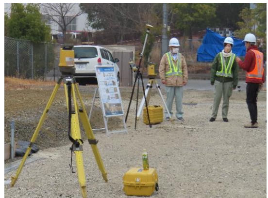
ICT活用工事
