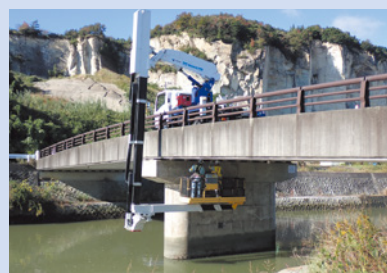
橋梁点検車による点検状況
