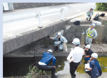
直営点検支援の状況
