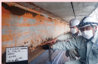
工事施工状況の確認
