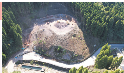
災害復旧工事（地すべり）
