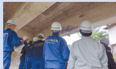
現場での経過観察状況
