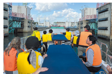
阪神湾岸インフラツアー (尼崎閘門【尼ロック】)
