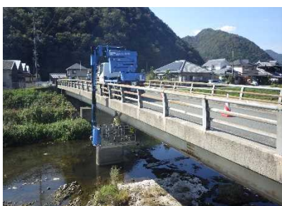
橋梁定期点検(橋梁点検車)
