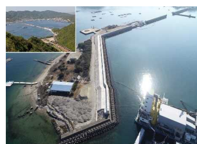
福良港 洲崎水門設置工事(南あわじ市)
