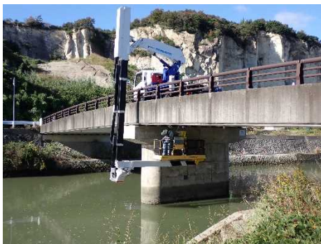
橋梁点検車による点検状況
