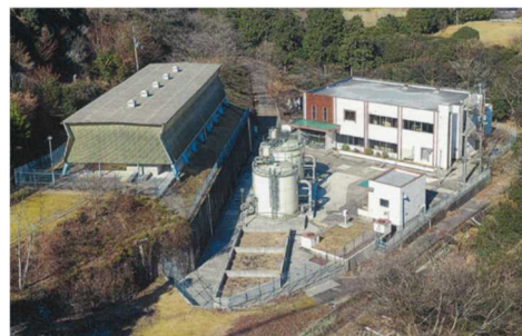
上田浄水場（淡路広域水道企業団）
