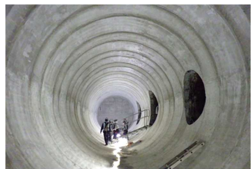
津門川地下貯留管
