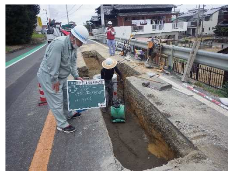
汚水管渠布設工事(淡路市)
