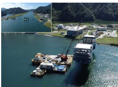
城崎大橋上部工事(豊岡市)
