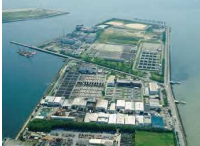
武庫川下流浄化センター(尼崎市)
