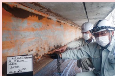
工事施工状況の確認
