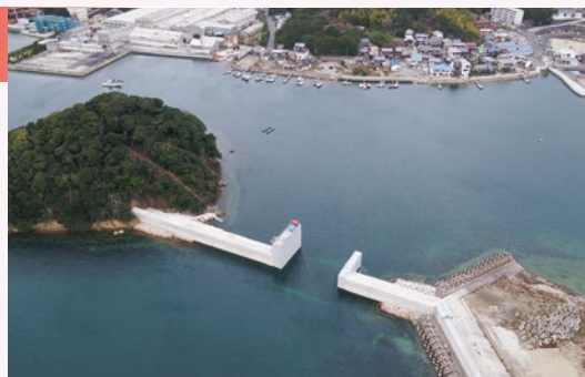
津波対策工事（湾口防波堤）
