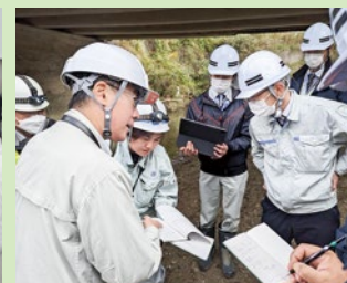
損傷状況を現場にて確認
