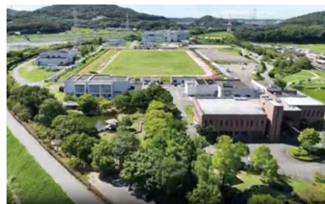
加古川上流浄化センターのドローン空撮動画
