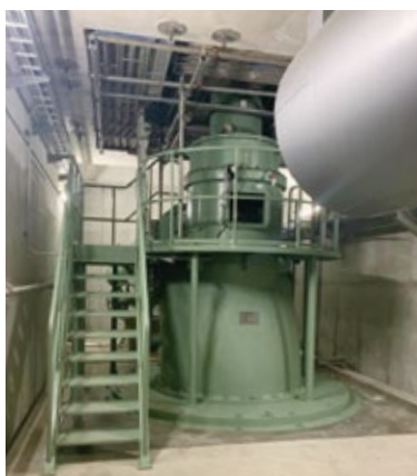
排水機場建設工事
