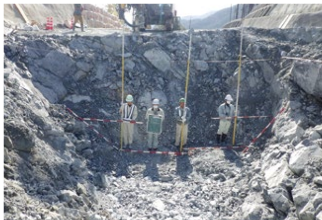
発破後の破碎範囲を確認
