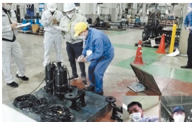
工場検査立会における遠隔臨場
