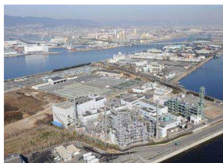
兵庫東スラッジセンター
