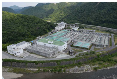
武庫川上流浄化センター
