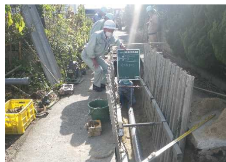
汚水管渠布設工事(南あわじ市)
