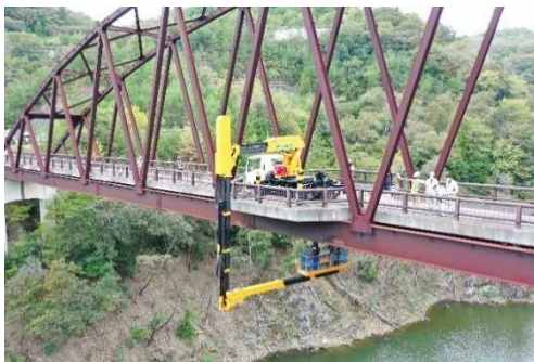
橋梁点検車による点検状況
