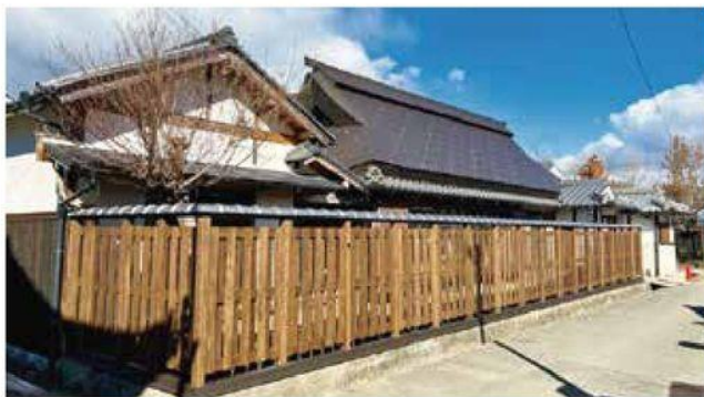
外観整備の事例（塀の修景）（丹波篠山市城下町地区）
