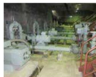
工事名：西部配水場更新工事 委託者：稲美町 受託内容：設計・積算・工事監理
