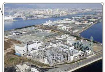
兵庫東スラッジセンター(尼崎市)
