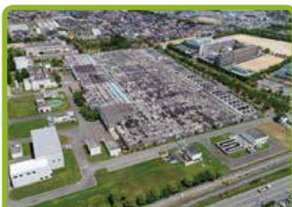
揖保川浄化センター(姫路市)
