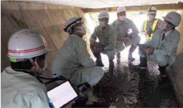
直営点検支援の状況
