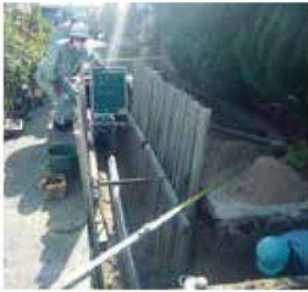
工事名：松帆・湊22号管渠 布設工事 委託者：南あわじ市 受託内容：設計・積算・工事監理
