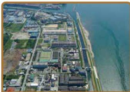
加古川下流浄化センター(加古川市)
