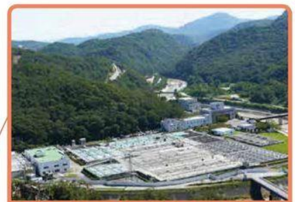
武庫川上流浄化センター(神戸市)
