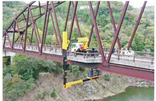
橋梁点検車による点検状況
