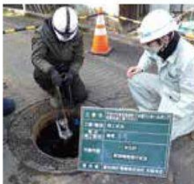
工事名：下水道マンホールポンプ 設備改築工事 委託者：新温泉町 受託内容：設計・積算・工事監理
