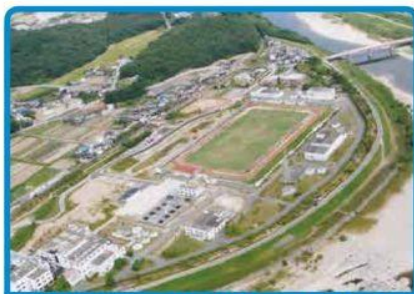
加古川上流浄化センター(小野市)
