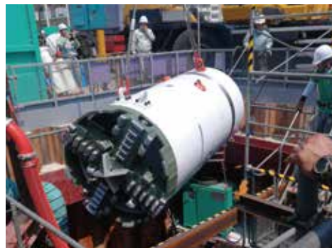
管渠シールド掘進機搬入
