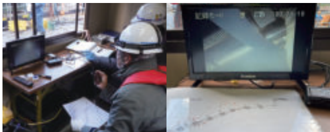
写真-3.底層放流設備・水中施工のモニター監理
