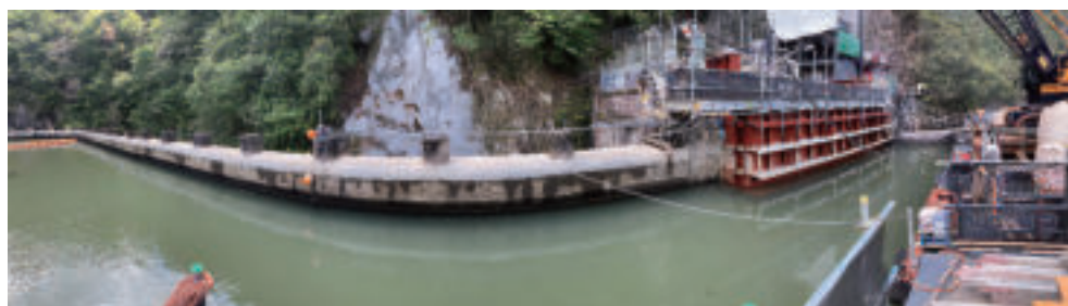
写真-2.既設副堤の一部を改修して放流設備を設置
