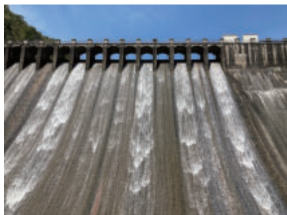
写真-1.主堰堤からの越流
