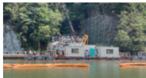
B 貯水池に設置された作業ヤード
