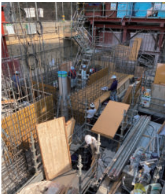
写真-4.現場状況
