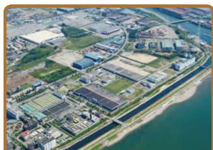
加古川下流浄化センター(加古川市)
