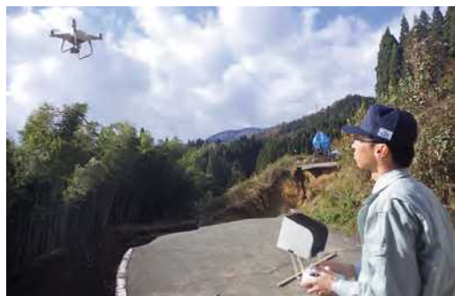
ドローンによる被災状況調査（香美町）
