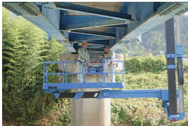
橋梁点検の状況
