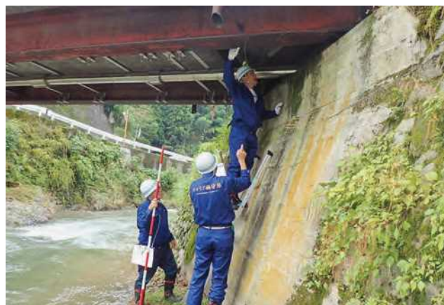
市町橋梁の経過観察
