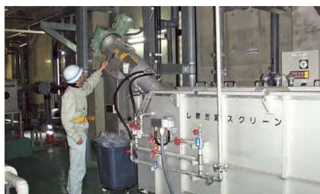
香美町 污水处理施設共同整備工事
