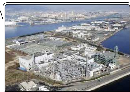
兵庫東スラッジセンター(尼崎市)
