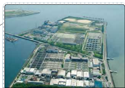
武庫川下流浄化センター(尼崎市)
