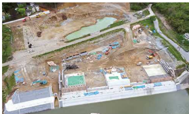
(二) 武庫川遊水地整備工事 施工状況（ICT活用工事）
