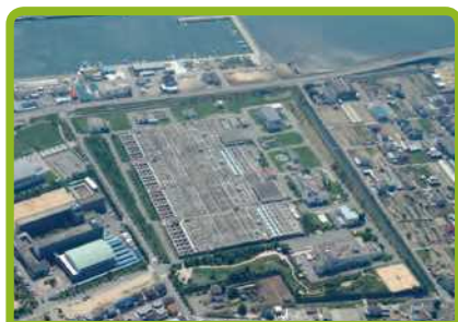
揖保川浄化センター(姫路市)
