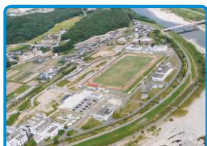
加古川上流浄化センター(小野市)
