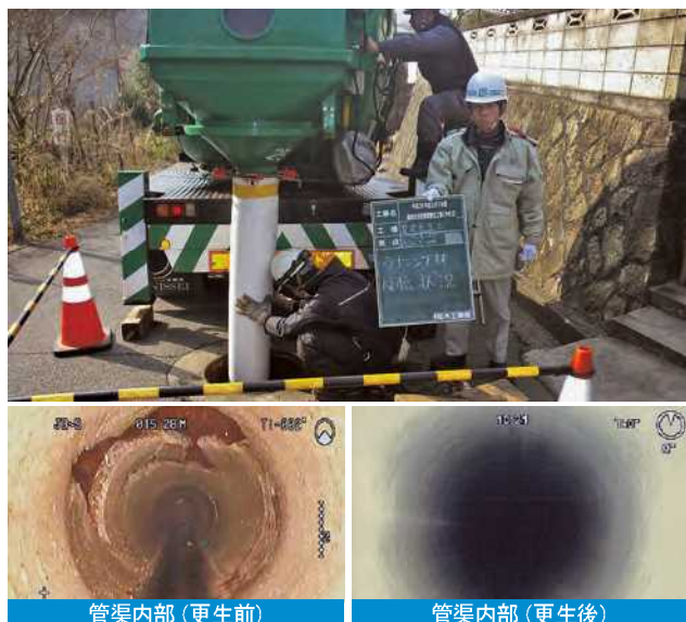
管渠内部（更生前）
