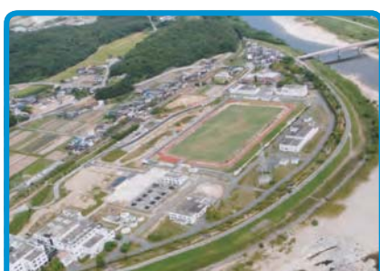
加古川上流浄化センター(小野市)
