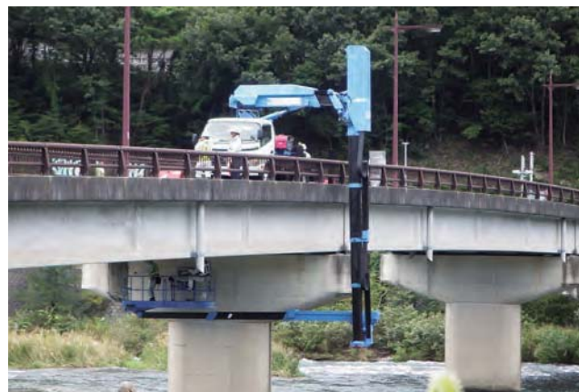
橋梁点検の状況
