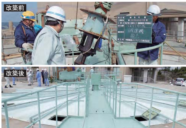
工 事 名：五色浄化センター機械設備改築工事 委 託 者：洲本市 受託内容：積算・工事監理
