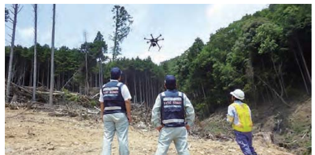
ドローンによる3次元測量
