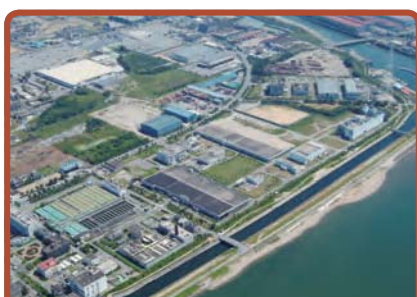
加古川下流浄化センター(加古川市)
