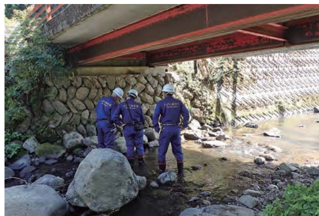
市町橋梁の経過観察
