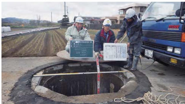
工 事 名：管渠布設工事（市・榎列処理区） 委 託 者：南あわじ市 受託内容：積算・工事監理
