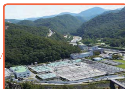
武庫川上流浄化センター(神戸市)
