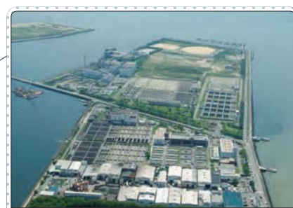
武庫川下流浄化センター(尼崎市)
