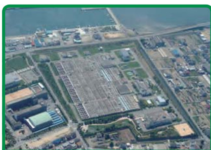
揖保川浄化センター(姫路市)
