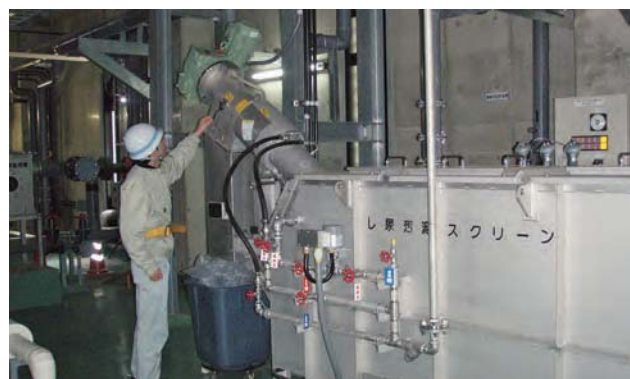
香美町 污水处理施設共同整備工事
