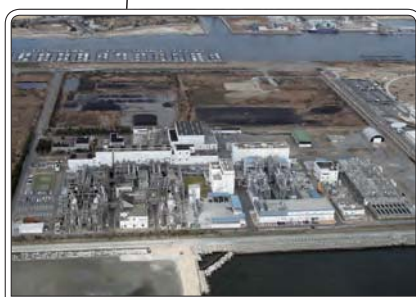
兵庫西スラッジセンター(姫路市)
