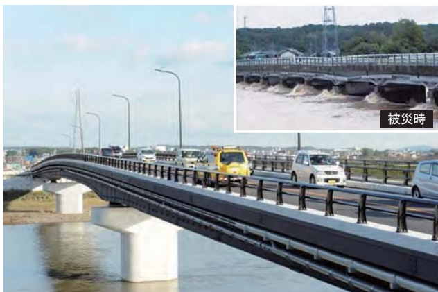
主要地方道三木穴栗線 粟田橋(小野市)
