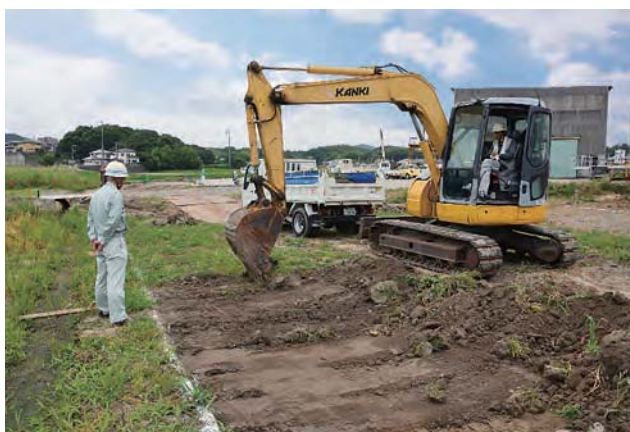
機械掘削（大円道向遺跡・淡路市）
