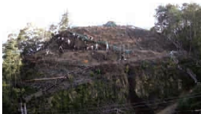
人力掘削（喜多・城山城跡 西脇市）
