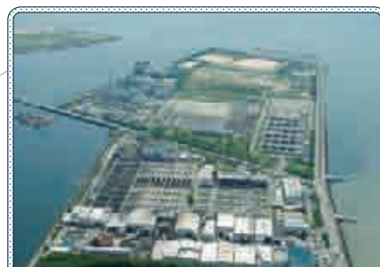
武庫川下流浄化センター(尼崎市)
