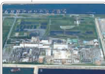
兵庫西スラッジセンター(姫路市)
