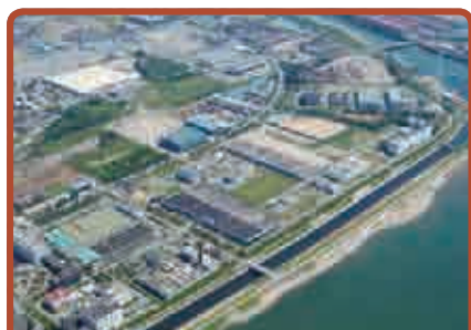
加古川下流浄化センター(加古川市)
