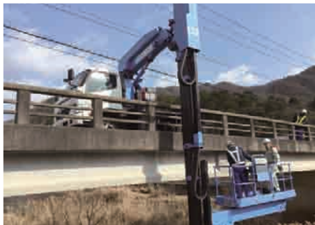
橋梁点検の状況写真
