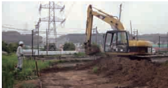
機械掘削（日下部遺跡 神戸市）
