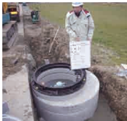
佐用町 処理場統廃合工事（接続管渠空気弁）
