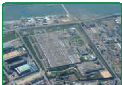
揖保川浄化センター(姫路市)
