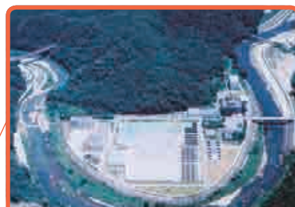
武庫川上流浄化センター(神戸市)
