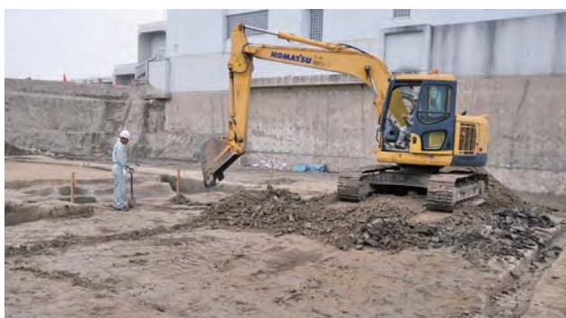
機械掘削（原田西遺跡・伊丹市）
