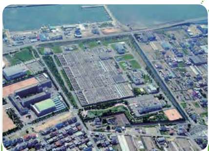
揖保川浄化センター
