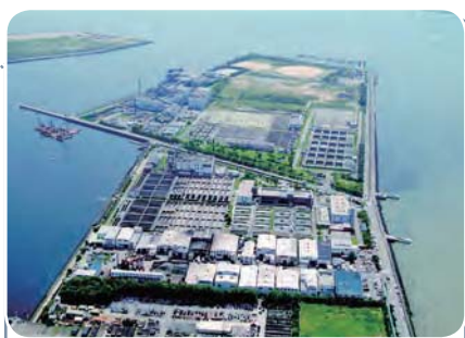
武庫川下流浄化センター
