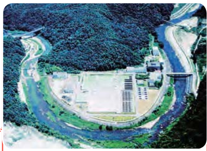
武庫川上流浄化センター
