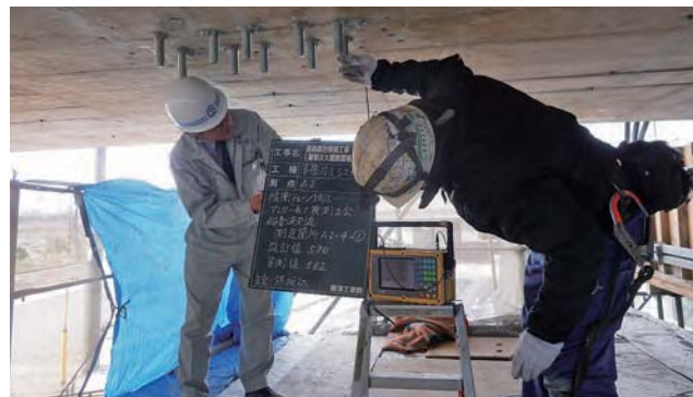
(工事監理の状況写真)
