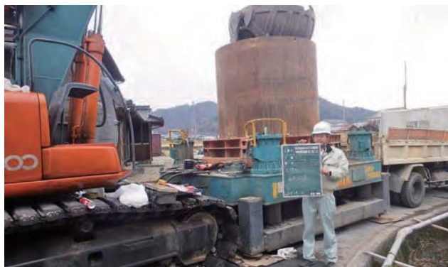
工 事 名：中部処理区面整備工事（第8工区） 委 託 者：市川町 委託内容：積算・工事監理
