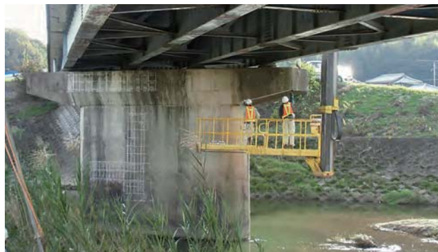
(橋梁点検の状況写真)
