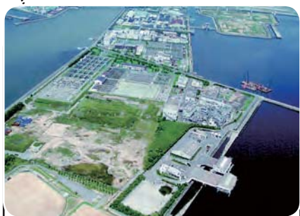
兵庫東スラッジセンター
