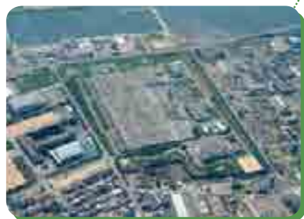
揖保川浄化センター
