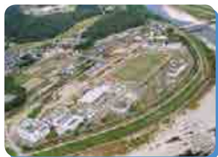
加古川上流浄化センター
