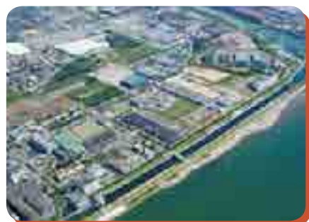
加古川下流浄化センター
