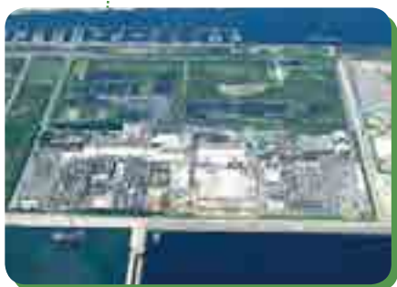
兵庫西スラッジセンター
