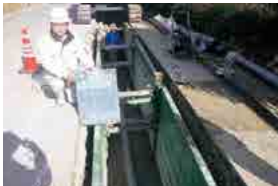
工 事 名：管渠布設工事（中田工区第 70 工区） 委 託 者：淡路市 受託内容：積算・工事監理
