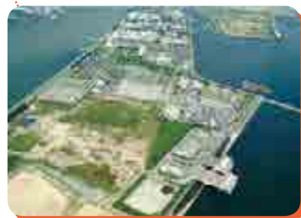
兵庫東スラッジセンター
