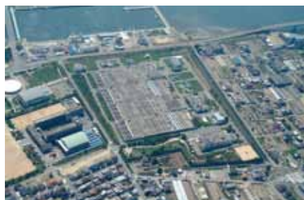
揖保川浄化センター
