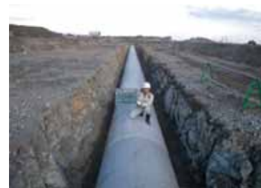
工事名：南鶴崎雨水・污水管渠布設工事 委託者：淡路市 受託内容：設計・積算・工事監理
