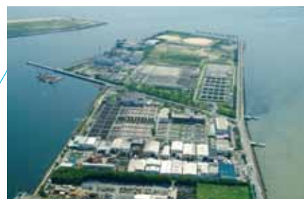
武庫川下流浄化センター
