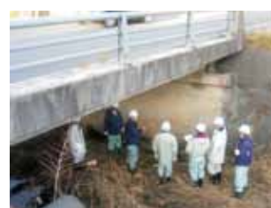
橋梁損傷確認状況
