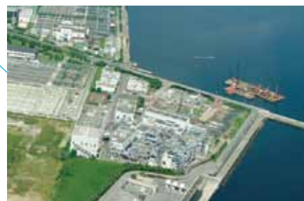
兵庫東スラッジセンター
