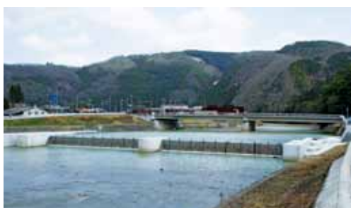
災害復旧事業 積算・工事監理支援
