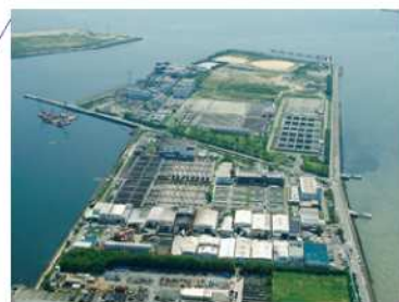
武庫川下流浄化センター
