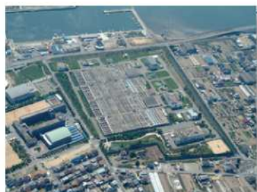
揖保川浄化センター
