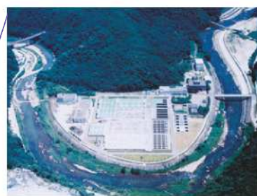
武庫川上流浄化センター
