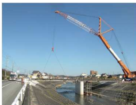
・工事名 (市)東条社線 大石橋上部工架設工事 ・委託者 加東市 ・積算・工事監理
