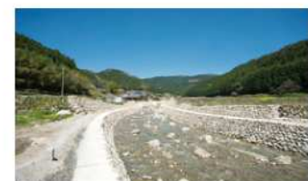
災害復旧事業 積算・工事監理支援
