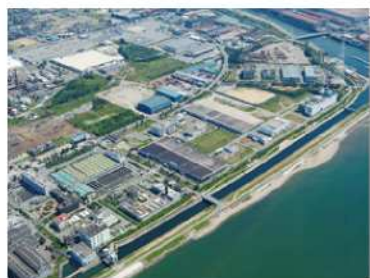
加古川下流浄化センター
