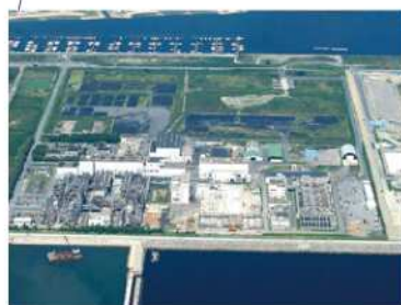
兵庫西スラッジセンター
