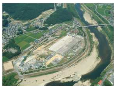
加古川上流浄化センター
