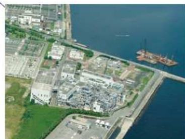
兵庫東スラッジセンター
