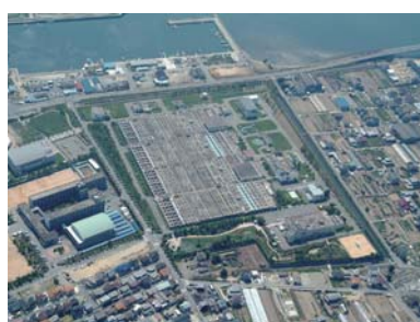
揖保川浄化センター
