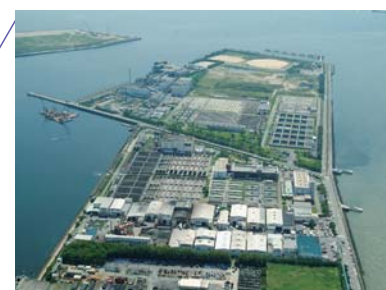
武庫川下流浄化センター
