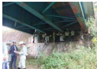
市町道橋梁点検研修
