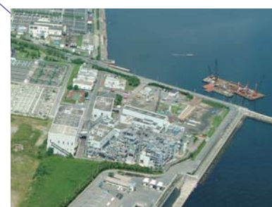
兵庫東スラッジセンター
