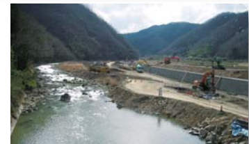
災害復旧事業 積算・工事監理支援
