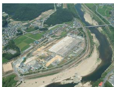
加古川上流浄化センター
