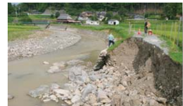
災害復旧職員派遣活動状況
