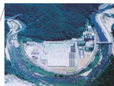
武庫川上流浄化センター
