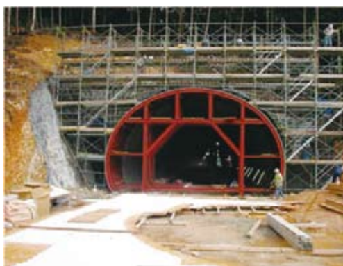
・工事名 (主) 篠山山南線 愛宕山トンネル建設工事 ・委託者 丹波土木事務所 ・積算・工事監理
