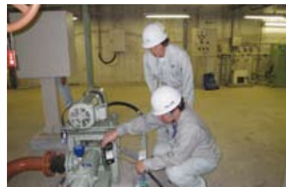
・工事名：洲本環境センター長寿命化計画策定業務 ・委託者：洲本市 ・施工監理
