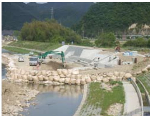
・工事名 (一) 加古川水系野間川 野間川 25 工区 (護岸工事) ・委託者 加東土木事務所 ・積算・工事監理
