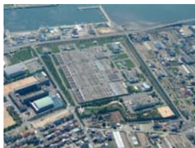
揖保川浄化センター
