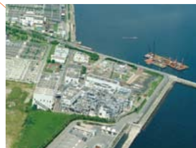
兵庫東スラッジセンター
