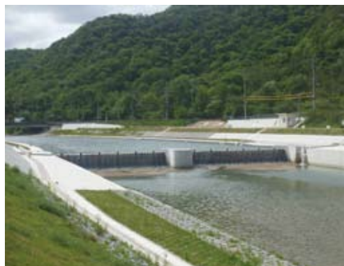
・工事名 (一) 加古川水系野間川 野間川井堰改築工事 (機械設備) ・委託者 加東土木事務所 ・積算・工事監理
