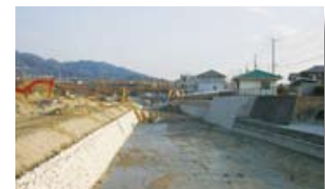
災害復旧事業 積算・工事監理支援
