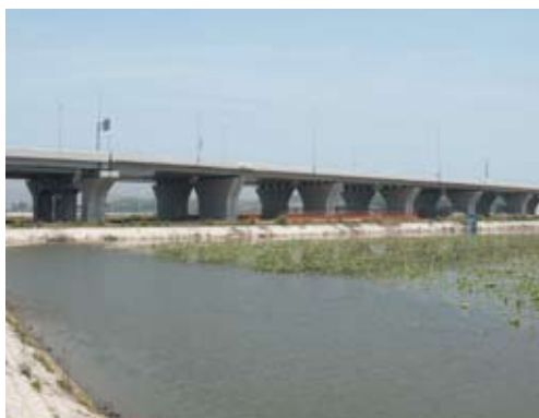
・工事名 東播磨南北道路 皿池 (第 15) 高架橋上部工工事 ・委託者 加古川土木事務所 ・積算・工事監理
