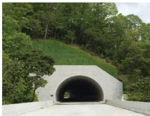
・工事名 (国) 178号余部道路 油良・間室トンネル建設工事 ・委託者 新温泉土木事務所 ・積算・工事監理
