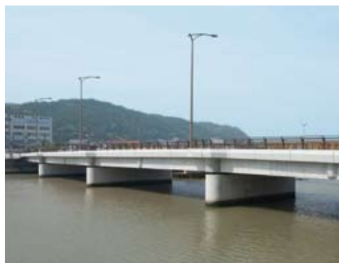
・工事名 (二) 洲本川水系洲本川 洲本橋上部工工事 ・委託者 洲本土木事務所 ・積算・工事監理
