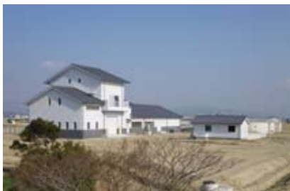
・工事名：松帆・湊浄化センター土木建築工事 ・委託者：南あわじ市 ・設計・施工監理
