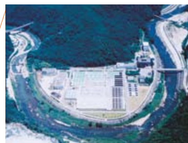
武庫川上流浄化センター
