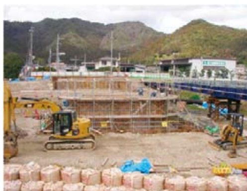
・工事名 (市)和田小新屋線 小新屋橋架替工事(その1) ・委託者 丹波市 ・積算・工事監理
