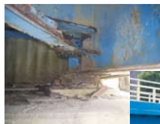
着手前 (沓座及び桁端部)
