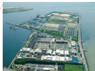
武庫川下流浄化センター
