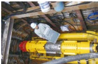
・工事名：中部第2汚水幹線布設その1工事 ・委託者：市川町 ・施工監理
