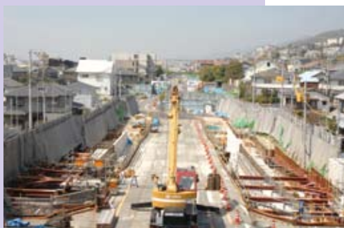
・工事名 山手幹線芦屋川横断工区 街路工事 ・委託者 西宮土木事務所 ・積算・工事監理
