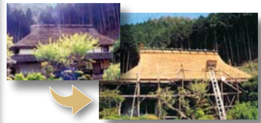
修景助成事例：茅葺き屋根の葺きかえ
