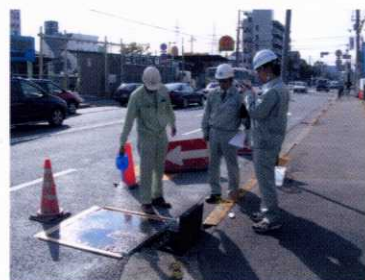
光触媒舗装調査状況
