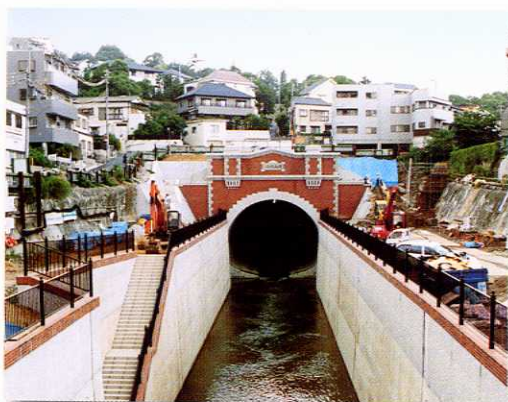
工事名 (二) 新湊川災害復旧助成工事 (トンネル吐口側工区) 工事監理 委託者 神戸県民局 (神戸土木事務所)
