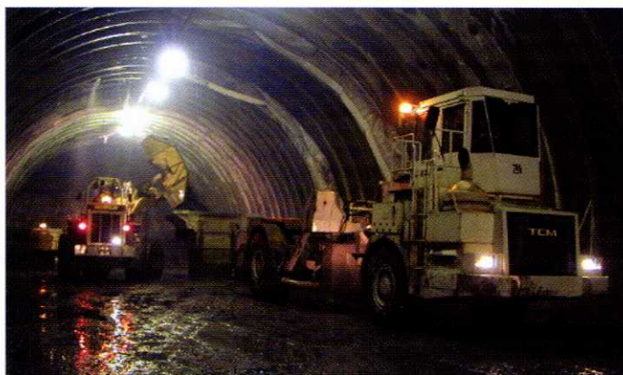
工事名 (国) 482号蘇武トンネル工事(村岡工区) 工事監理 委託者 但馬県民局(浜坂土木事務所)
