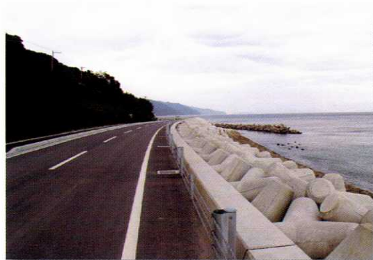
工事名 (主) 洲本南淡線道路改良工事 工事監理 委託者 淡路県民局(洲本土木事務所)
