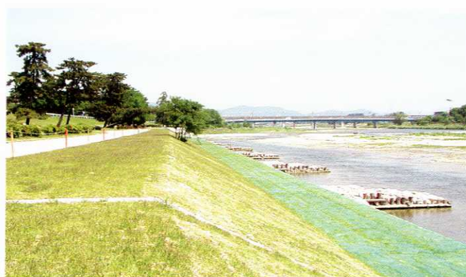
工事名 (二) 武庫川低水護岸工事 積算/工事監理 委託者 阪神南県民局 (西宮土木事務所)
