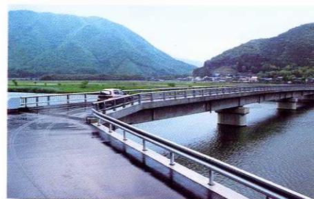
工事名 (町) 赤岩線赤松橋橋梁工事 工事監理 委託者 上郡町
