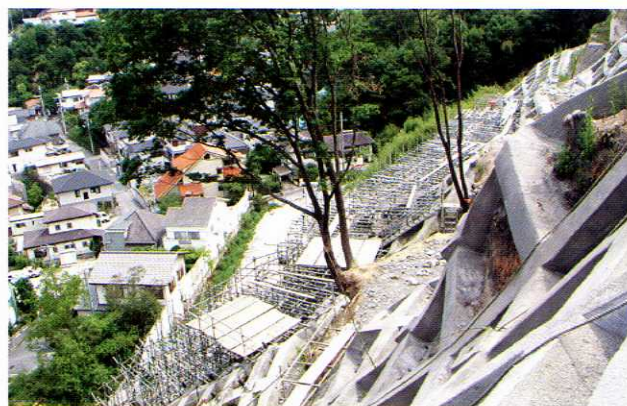
工事名 宝生ヶ丘地すべり防止工事 工事監理 委託者 阪神南県民局(西宮土木事務所)
