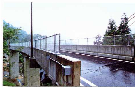
工事名 (町) 二見森津線高架橋橋梁工事 積算 委託者 城崎町
