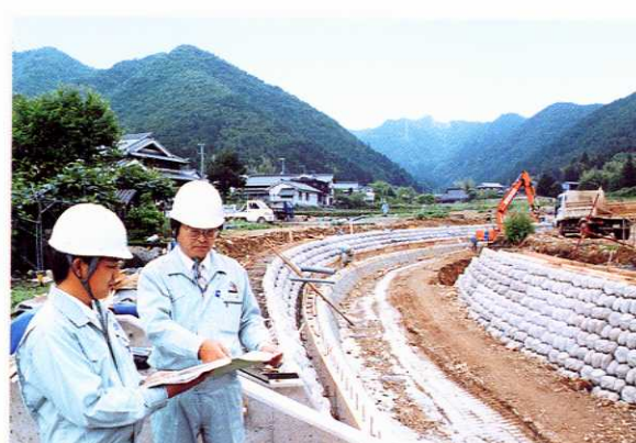
工事名 (一) 岩屋谷川河川災害復旧助成工事 積算/工事監理 委託者 丹波県民局 (柏原土木事務所)
