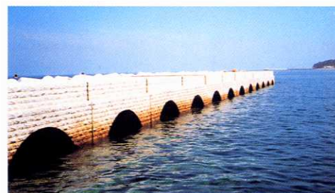
工事名 鳥飼海岸離岸堤工事 工事監理 委託者 淡路県民局(洲本土木事務所)
