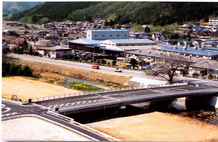
工事名 (一) 姫路新宮線芝田橋橋梁整備工事 工事監理 委託者 西播磨県民局 (龍野土木事務所)
