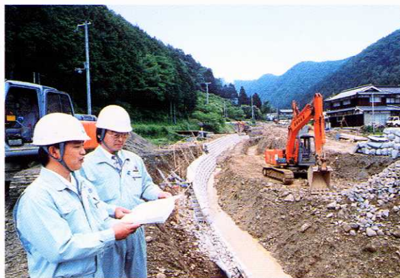
工事名 (一) 岩屋谷川砂防災害関連工事 積算/工事監理 委託者 丹波県民局(柏原土木事務所)
