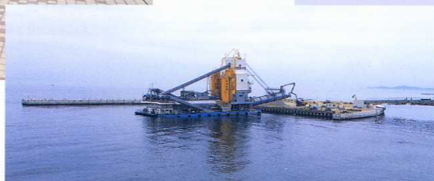
工事名 淡路交流の翼港(護岸・橋梁下部工)工事
