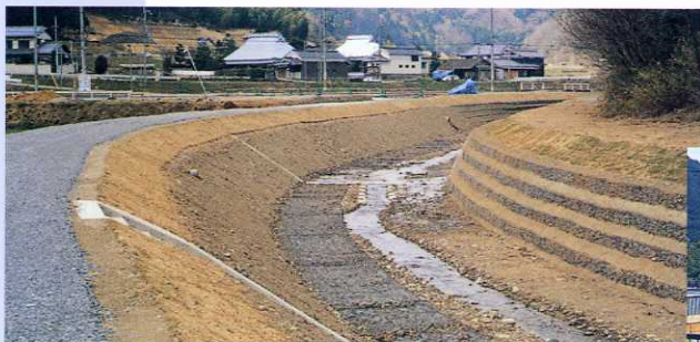
工事名 (二)須賀院川河川災害関連事業
