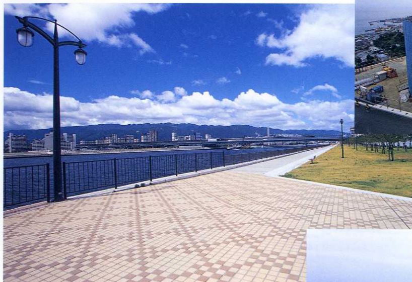
工事名 西宮浜地区公園・緑地整備工事
