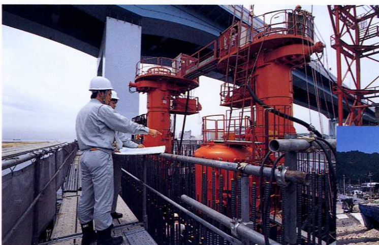
工事名 (一) 東灘芦屋線連絡橋P11ケーソン工事 積算/工事監理 委託者 兵庫県西宮土木事務所
