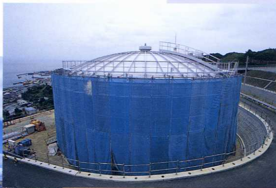
工事名 淡路調整池築造工事
