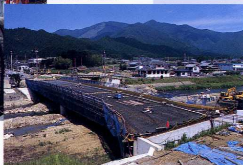
工事名 町道川東線松井庄大橋橋梁新設工事 積算 委託者 加美町
