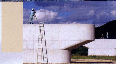
緊急地方道路整備事業（B）（紙園橋下部工事）
