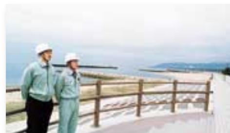
工事名 江井港護岸改良工事 積算/工事監理 委託者 淡路県民局(洲本土木事務所)
