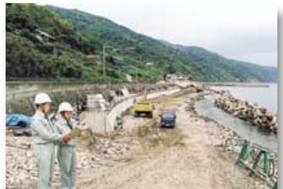
工事名 (主) 洲本南淡線道路改良工事 積算/工事監理 委託者 淡路県民局(洲本土木事務所)
