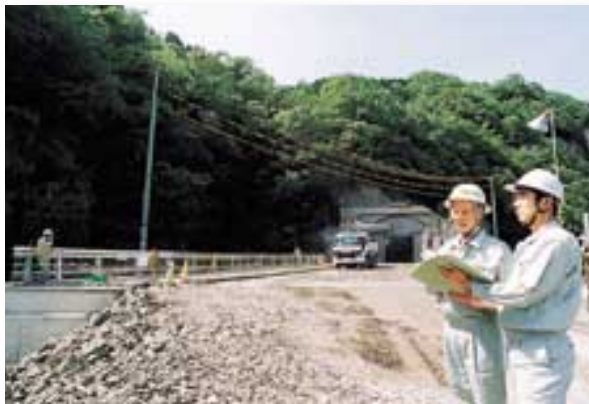
工事名 (国) 312号浅倉トンネル工事 積算/工事監理 委託者 但馬県民局(豊岡土木事務所)
