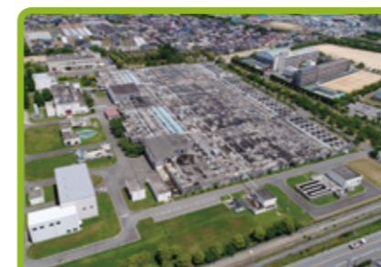
揖保川浄化センター(姫路市)
