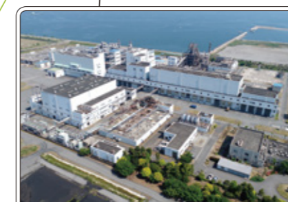
兵庫西スラッジセンター(姫路市)
