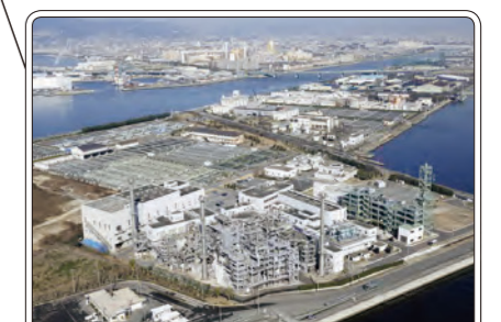
兵庫東スラッジセンター(尼崎市)
