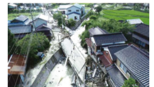
ドローンを活用した被災状況調査 (宍粟市:平成30年7月豪雨災害)
