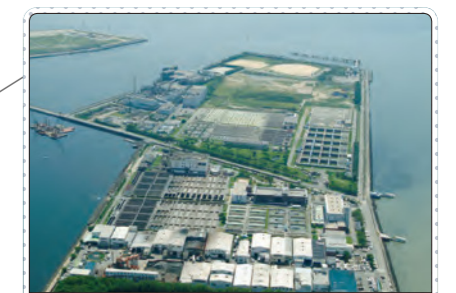
武庫川下流浄化センター(尼崎市)
