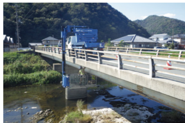
橋梁点検車による点検状況
