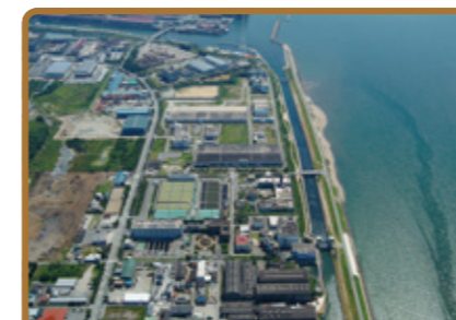
加古川下流浄化センター(加古川市)
