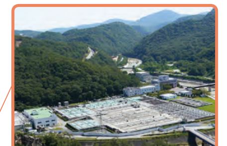
武庫川上流浄化センター(神戸市)
