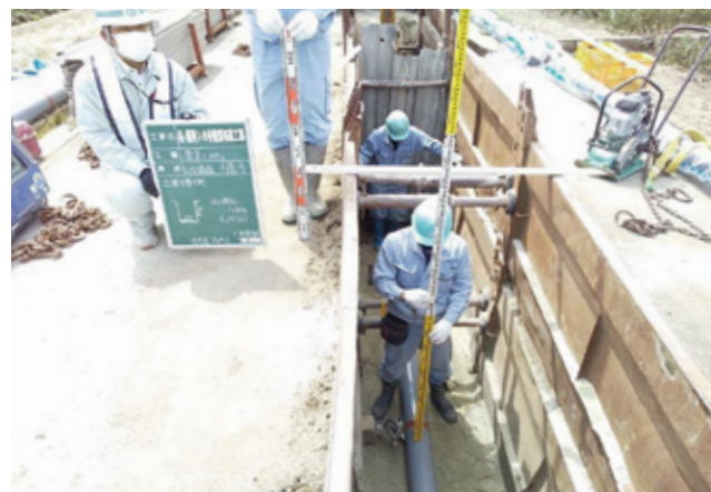
工事名：市・榎列16号管渠布設工事 委託者：南あわじ市 受託内容：設計・積算・工事監理
