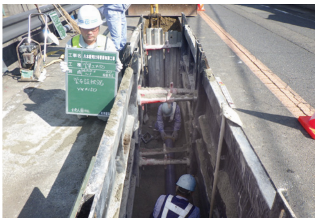
工 事 名：八木榎列22号管渠布設工事 委 託 者：南あわじ市 受託内容：設計・積算・工事監理
