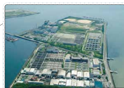
武庫川下流浄化センター(尼崎市)
