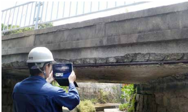
直営点検支援の状況
