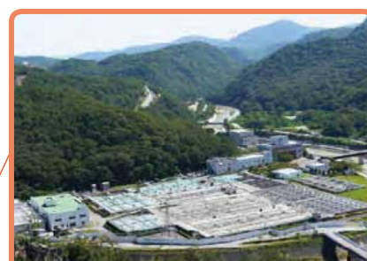
武庫川上流浄化センター(神戸市)
