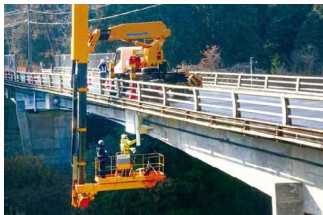
橋梁点検車による点検状況
