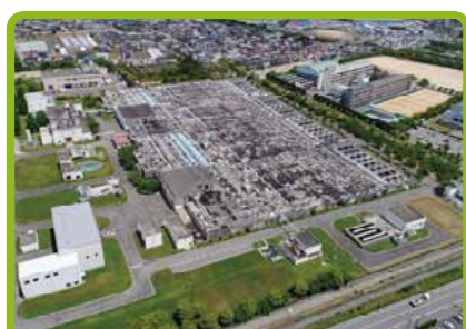
揖保川浄化センター(姫路市)
