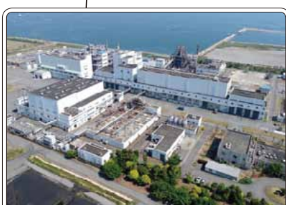
兵庫西スラッジセンター(姫路市)
