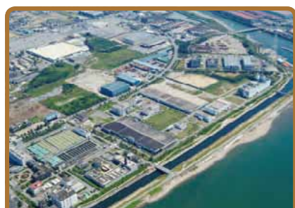
加古川下流浄化センター(加古川市)
