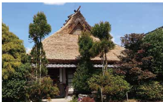
外観整備の事例（茅葺屋根の葺き替え） （丹波篠山市城下町地区 市景観条例歴史地区）
