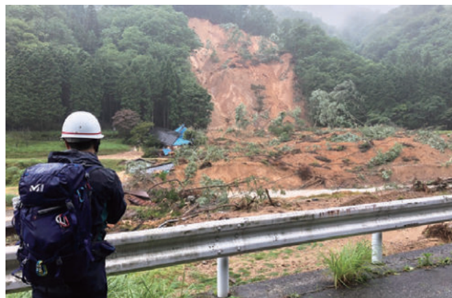
写真-1 一宮町公文地区の山腹崩壊
