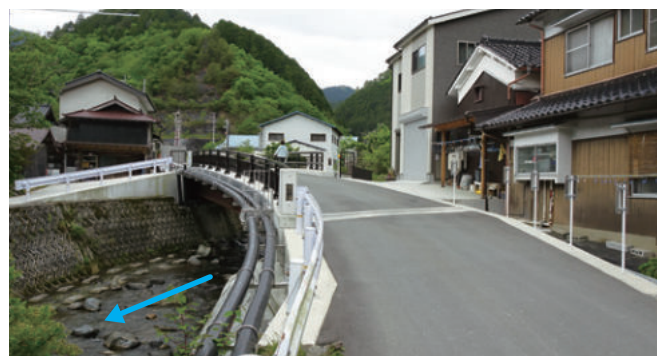
完成した椿下橋
