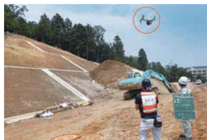
ICT 活用工事の監理
