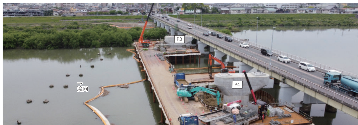
下部工工事の様子
