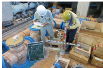
配管材料検収
