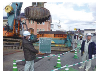
立坑築造状況確認
