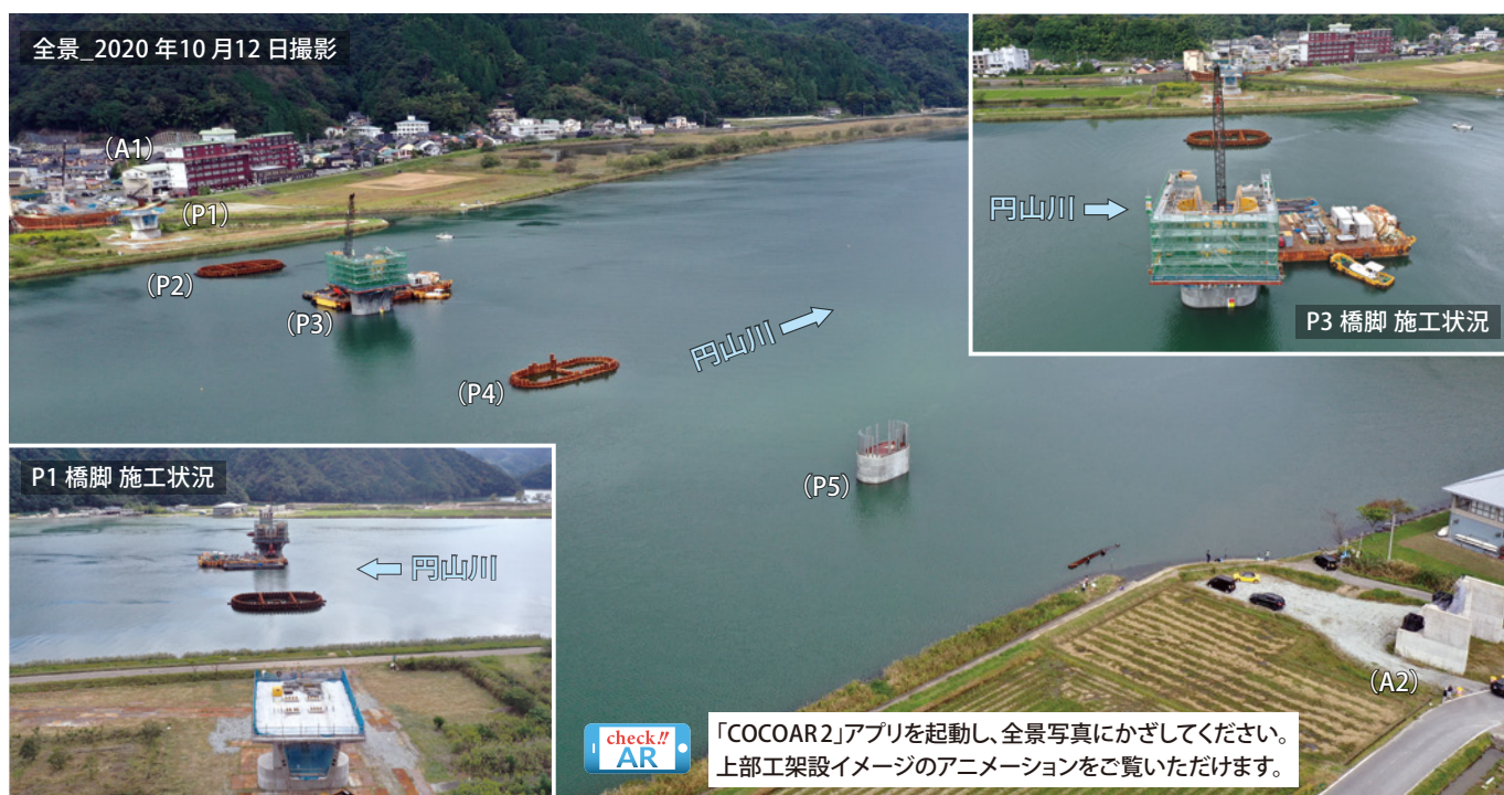
(新)城崎大橋 施工状況
