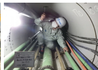
一次覆工出来形確認(推進管)
