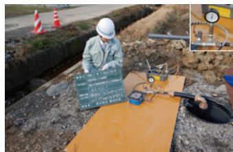
配管水圧試験
