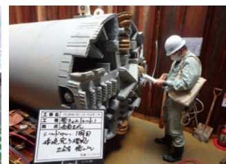
シールド掘進機整備確認
