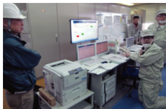
監視制御装置試運転
