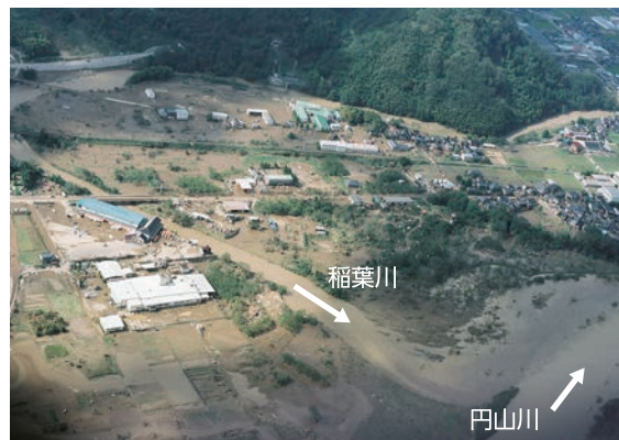
平成16年台風第23号による被災状況（全景）
