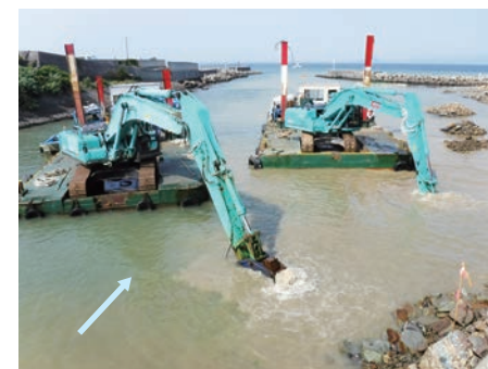
バックホウによる浚渫
