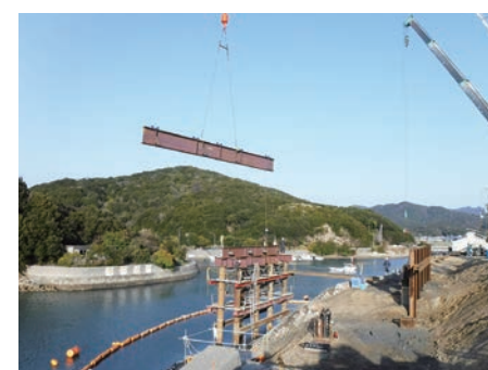
仮栈橋の組立て
