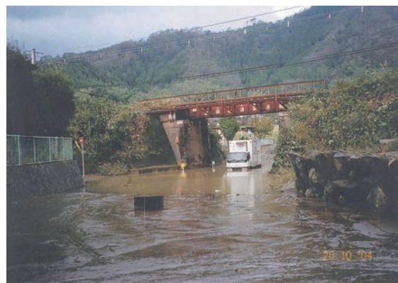
平成16年台風第23号による被災状況（JR山陰線交差付近）
