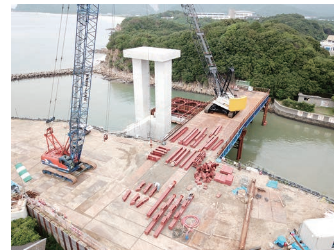
現況(令和元年7月)
