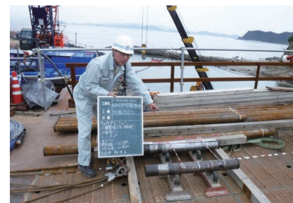
地盤改良工の資材検認(難波所長)
