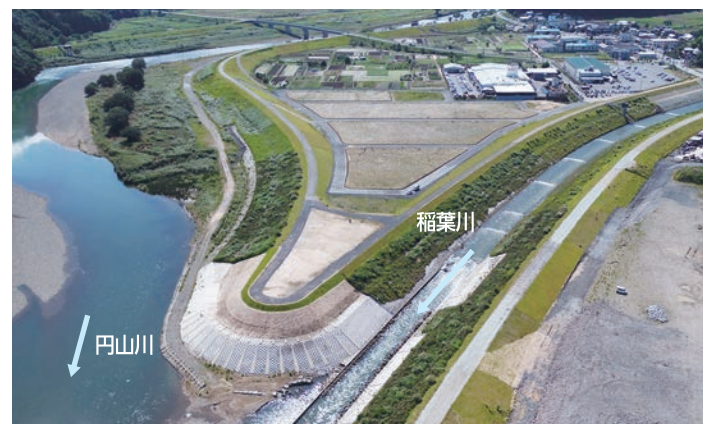
堤防が完成した合流点付近
