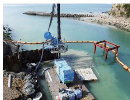
仮締切の矢板打設
