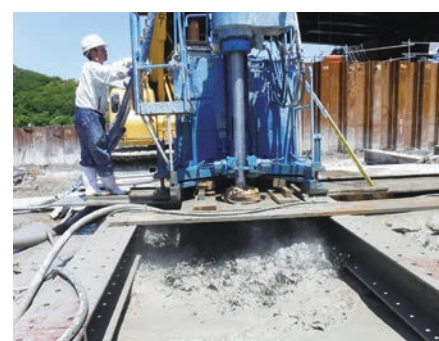
仮締切内での地盤改良
