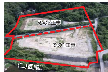
施行前の状況(ドローンで撮影)
