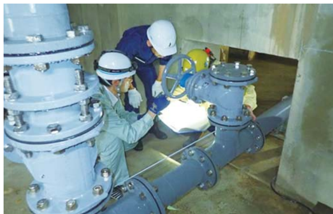
船津浄水場送水ポンプ井改修工事の現場立会
