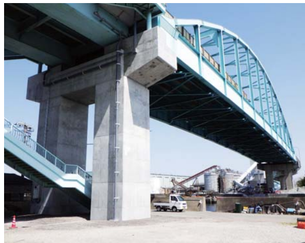
新設橋脚のように変わった工事完成後のP6橋脚
