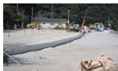
施行中(区画街路)
