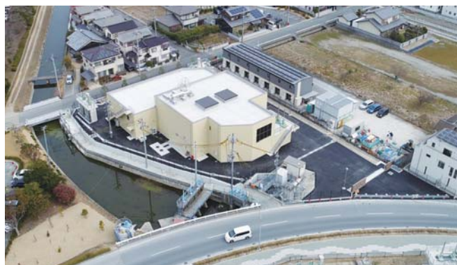
高砂市 間の川ポンプ場
