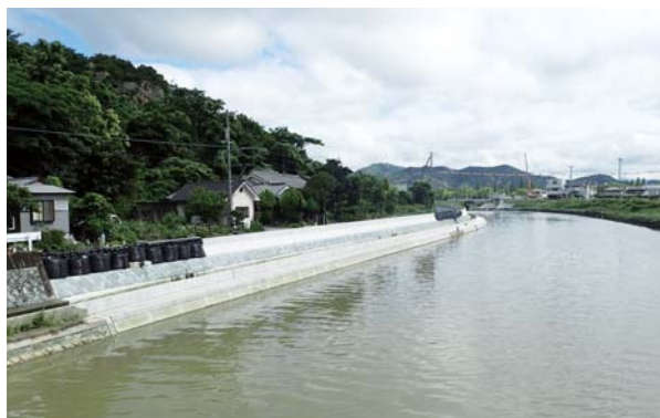
完成した護岸(高砂市米田町塩市付近)
