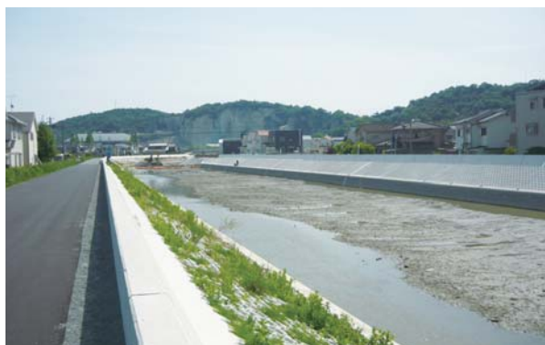
完成した護岸(高砂市米田町島付近)
