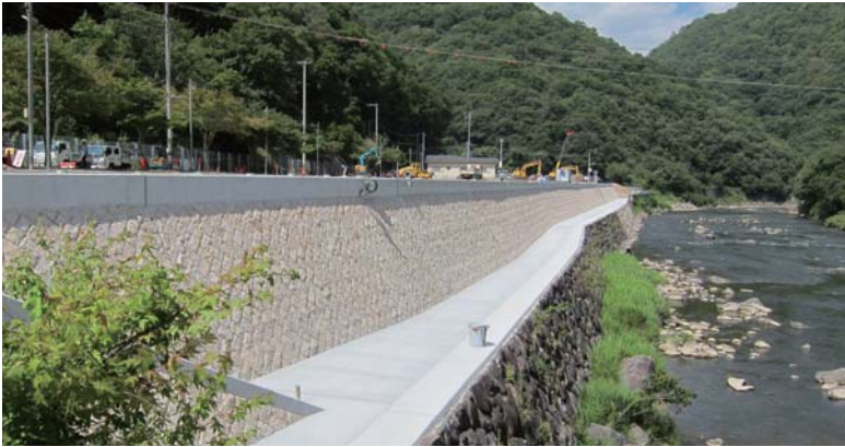
完成した河川護岸
