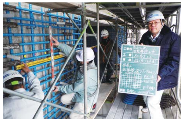
エポキシ樹脂鉄筋配筋検査の状況
