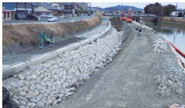
河川改修工事の状況(高砂市伊保港町付近)
