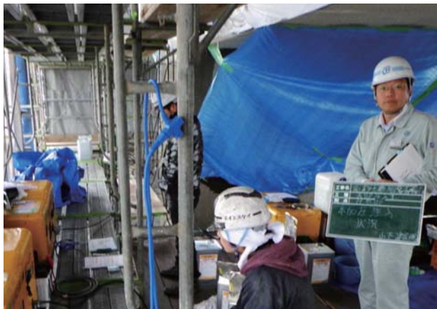
亜硝酸リチウム圧入管理の状況
