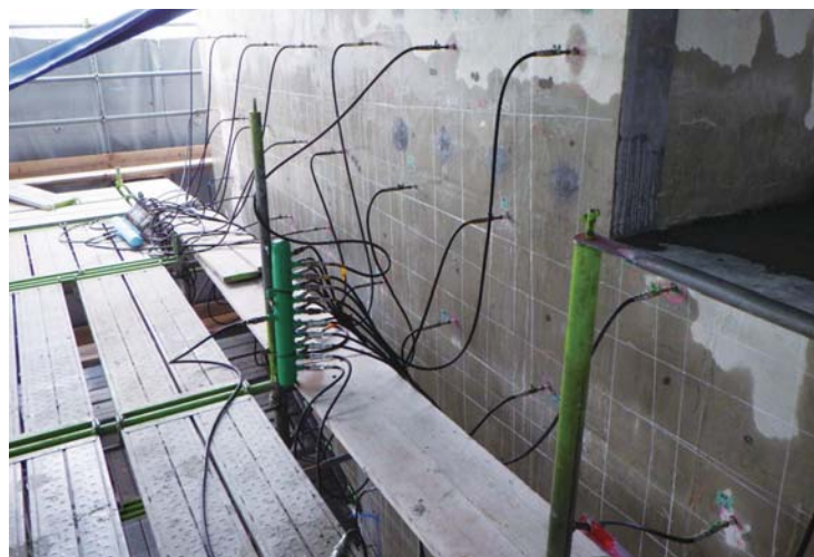
亜硝酸リチウム圧入状況
