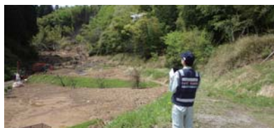
ドローンによる空撮状況
