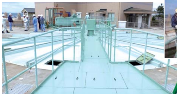
洲本市五色浄化センター機械設備改築工事
