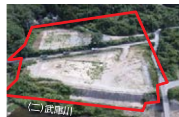
着工前(センターのドローンで撮影)
