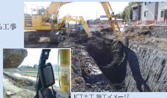
ICT土工 施工イメージ
