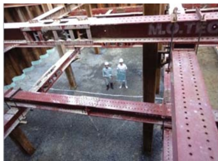
淡路市津名浄化センター沈砂池・ポンプ棟建設工事
