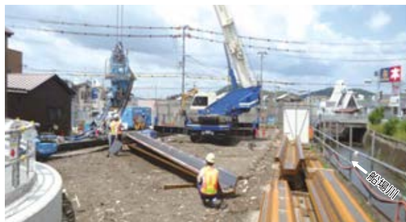
鋼矢板の打設状況(分水施設本体工事)
