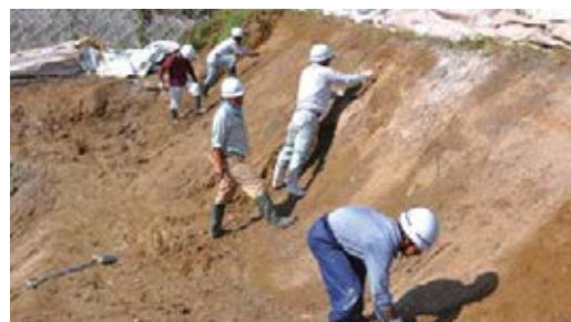
壁面精査状況
