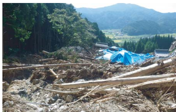
豪雨により流出した土砂、流木
