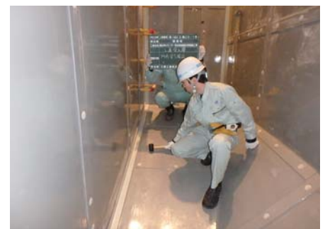
受入槽防食塗装 (検査)
