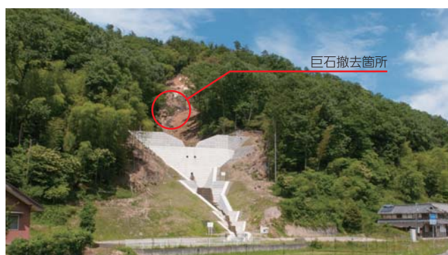
徳尾西谷川砂防えん堤
