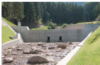
県施工による砂防えん堤
