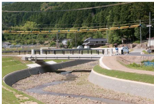
整備された一級河川徳尾川と鴨阪橋
