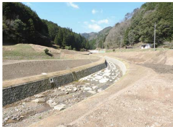
多自然型の川として復旧した山田川(改良復旧事業)
