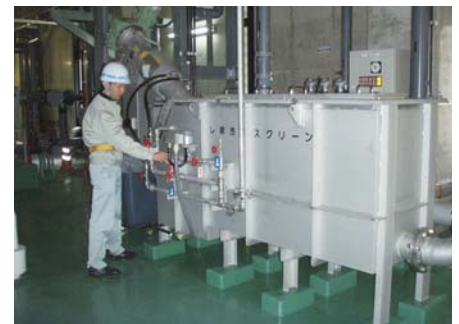
し尿スクリーン新設 (据付状況)
