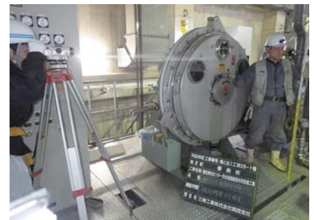
汚泥脱水機増設 (据付状況)
