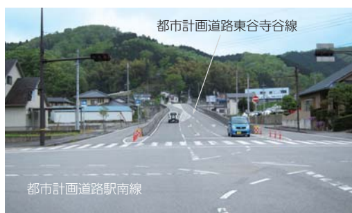
国道9号に繋がる都市計画道路東谷寺谷線
