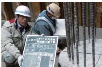
技術第1課 矢代副課長 担当：工事監理【下部工工事】
