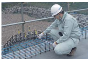
技術第2課 梅本副課長 担当：積算・工事監理【上部工工事】
