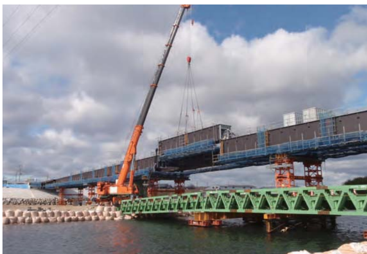
新橋の橋桁閉合
