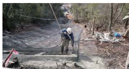
吹付法砕工 (ユニラップ工法)
