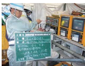
注入状況立会い
