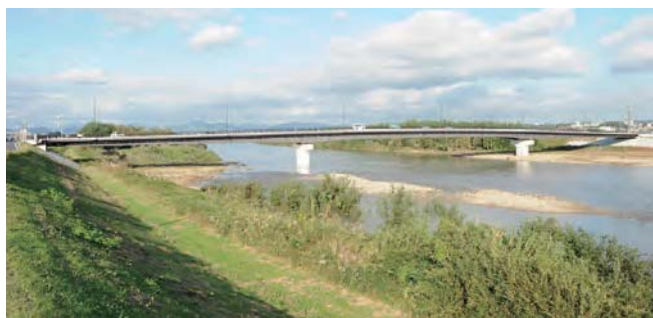
2本の橋脚が特徴的な新しく架け替えられた「栗田橋」
