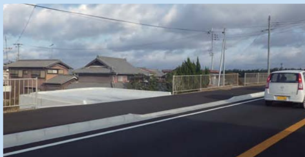
道路との高低差が著しい所では、駐車場を道路の高さに合わせました
