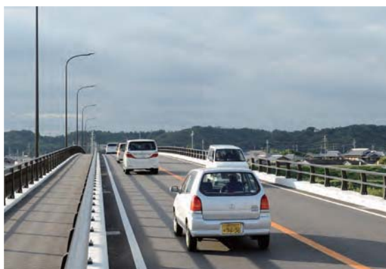
道路が拡幅したことで、安全性・快適性が向上しました
