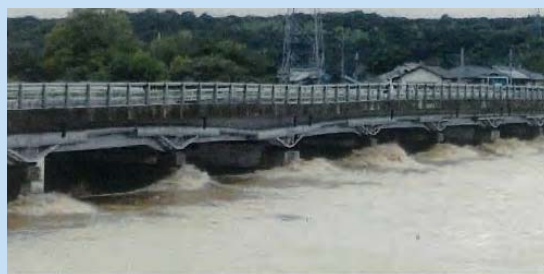
増水時の栗田橋上流側の状況
