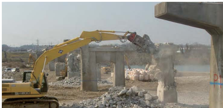
旧橋撤去(下部工)
