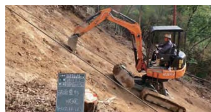
法面整形 (SSD 工法)
