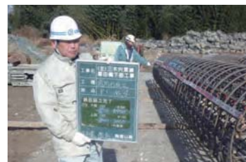
技術第1課 原副課長（現播磨事務所） 担当：積算・工事監理【旧橋撤去工事、下部工工事】
