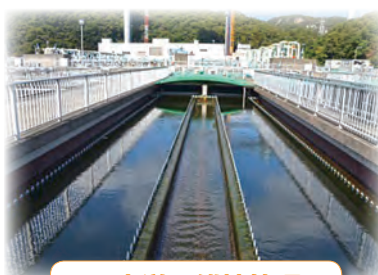
下水道の維持管理
