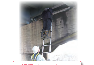
橋梁メンテナンス
