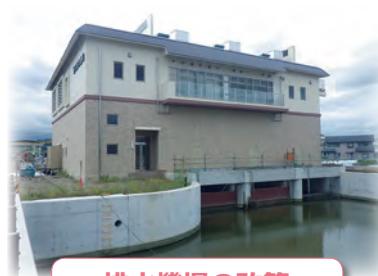
排水機場の改築
