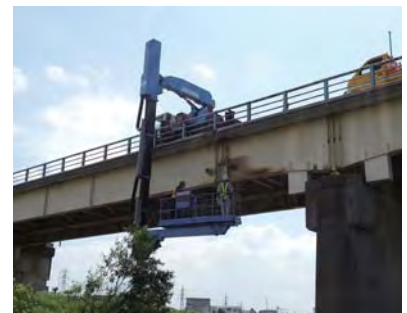
橋梁定期点検状況
