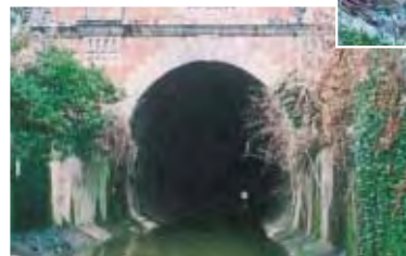
震災前の吐口側坑門
