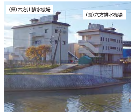
排水機場全景
