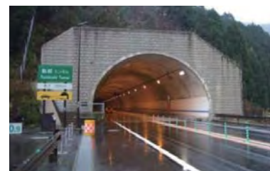
船越トンネル終点側坑門(余部工区側)
