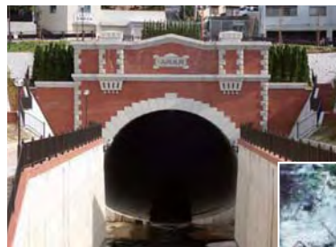
現在の吐口側坑門
