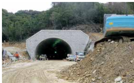
トンネル工事は、掘削後すぐにコンクリートを吹き付けるNATM工法*を採用
