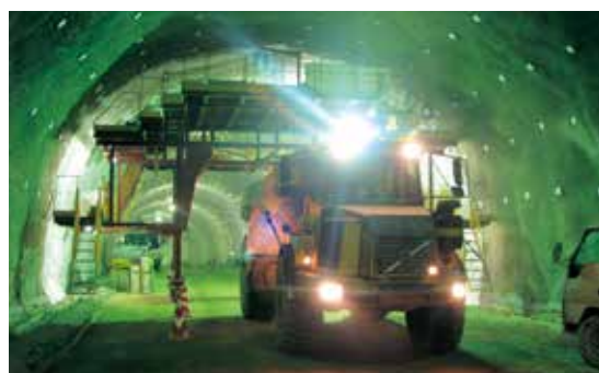
狭いトンネル内で方向転換できる大型ダンプカーを使用
