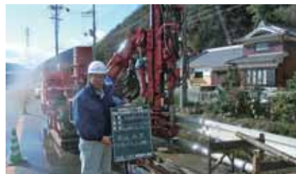
管渠布設工事「市川町 中部第2污水幹線（第8工区）」
