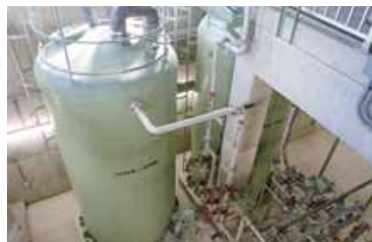
共同污水处理施設工事（汚泥貯留タンク）（新温泉町 浜坂浄化センター）
