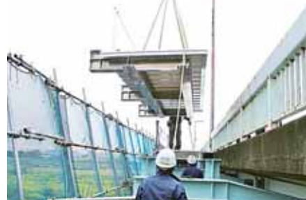
<池尻橋> 床版架設状況
