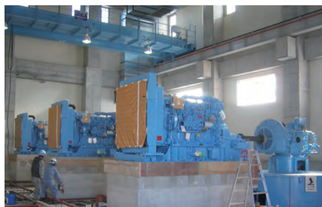
地域を水害から守る心臓部のポンプ(Φ1500)3台、ディーゼルエンジン出力260kw(354馬力)を3台設置
