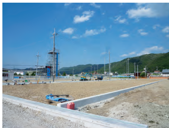
工事状況(H26.5現在)
