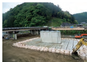
P1橋脚(下流右岸より)
