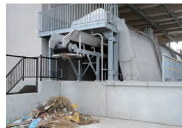
吸水時に流れてくるゴミを取り除く除塵機
