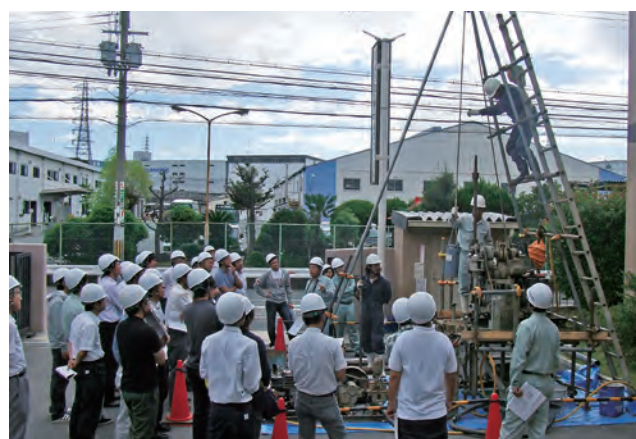
地盤調査・試験演習
