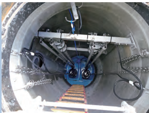
マンホールポンプ設置工事【淡路市 志筑地区天神】
