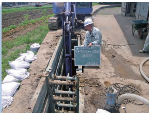
管渠布設工事【南あわじ市 市・榎列10号】
