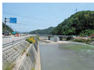
多賀橋（下流右岸より）
