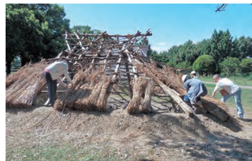
写真3 屋根葺きの状況（加古郡播磨町国指定史跡大中遺跡）
