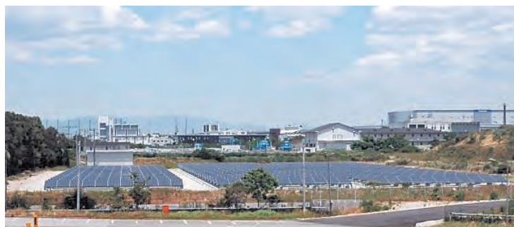
武庫川下流浄化センター
