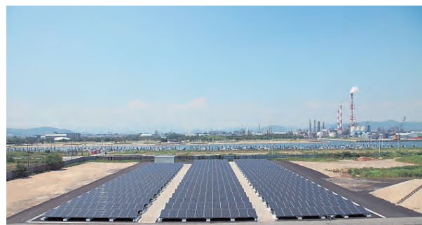
揖保川浄化センター
