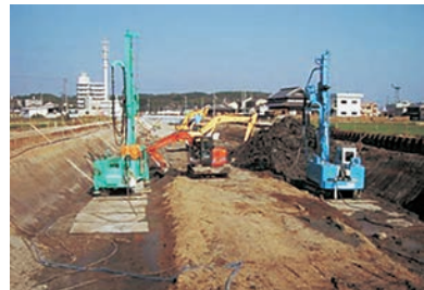
地盤改良（スラリー攪拌工）施工
