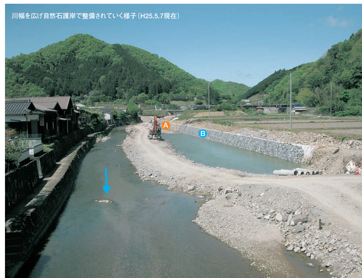
アンカー付空石積工法で整備された護岸 (写真左側は御殿屋敷跡の石垣の石 A、右側は購入自然石 B で形成されている)
