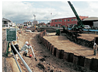
押さえ盛土状況
