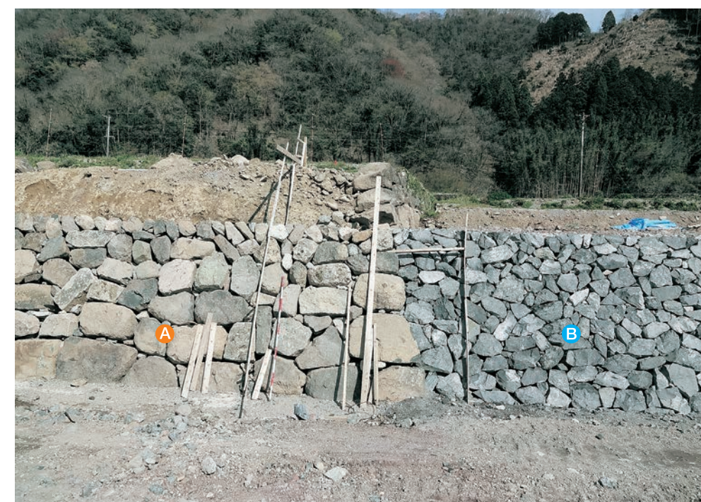
アンカー付空石積工法で整備された護岸 (写真左側は御殿屋敷跡の石垣の石 A、右側は購入自然石 B で形成されている)
