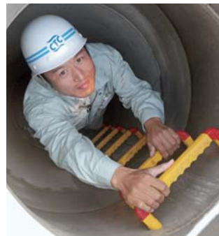
下水道管工事の計画設計施工監理に従事
