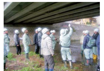
橋梁点検講習会状況
