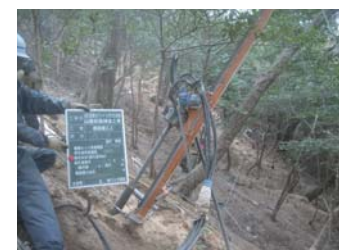
スタンドドライブ工法削孔状況
