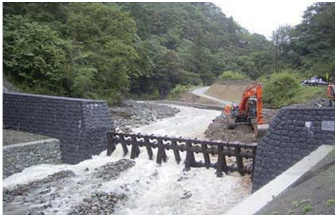
捕捉後の除石状況
