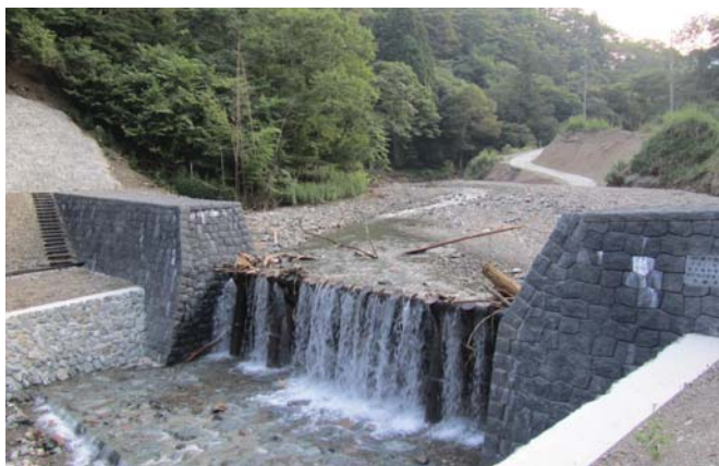
平成23年台風12号時 透過型砂防えん堤が土砂と流木を捕捉
