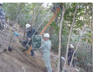
鉄筋挿入状況確認
