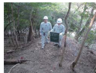
鉄筋挿入工打設箇所確認
