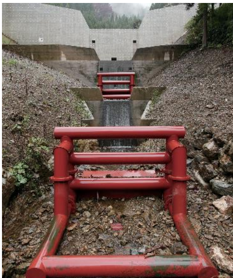
（砂）俣谷川 砂防えん堤
