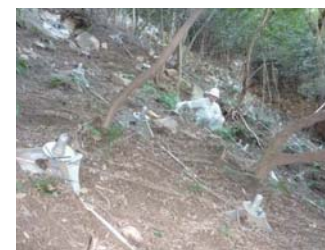
ノンフレイム工法設置状況確認
