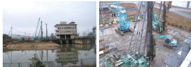
鋼管杭施工状況
